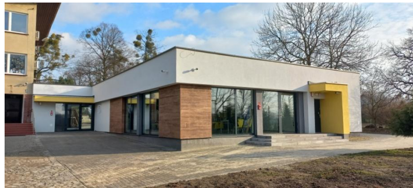
Ryc. 15.2.3 Inwestycja realizowana w ramach zadania „Budowa stołówki przy SP w Kozłowie”
