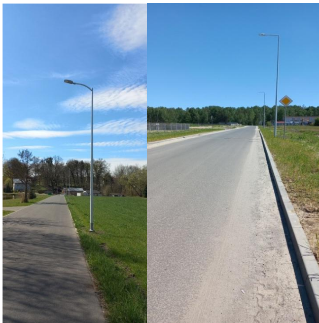
Ryc. 15.2.5 Inwestycje realizowane w ramach zadań „Budowa oświetlenia drogowego w miejscowości Sośnicowice przy ul. Szkolnej oraz Łany Wielkie przy ul. Szkolnej i ul. Wiejskiej” (fot. po lewej) oraz „Budowa drogi przy ul. Smolnickiej w Sośnicowicach wraz z kanalizacją deszczową i sanitarną” (fot. po prawej)
