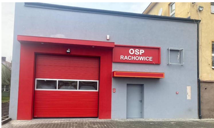
Ryc. 15.2.2 Zmodernizowany garaż OSP Rachowice
